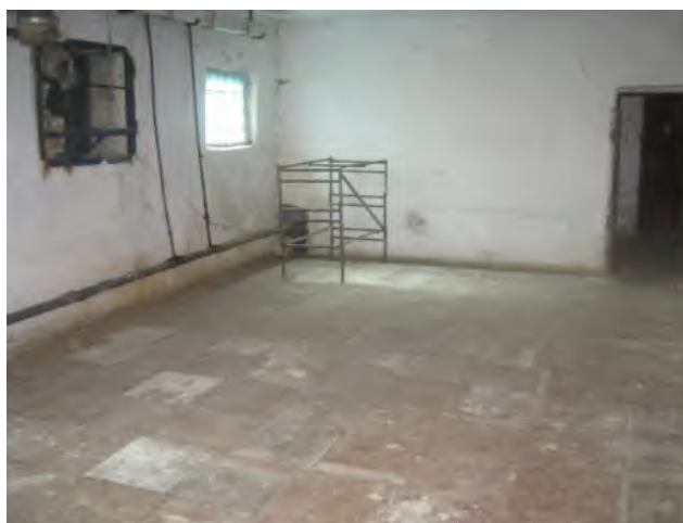
Рис. 1. Подвальное помещение под организацию лаборатории
