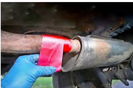
Рис. 9. Ремонт с помощью бандажной ленты
