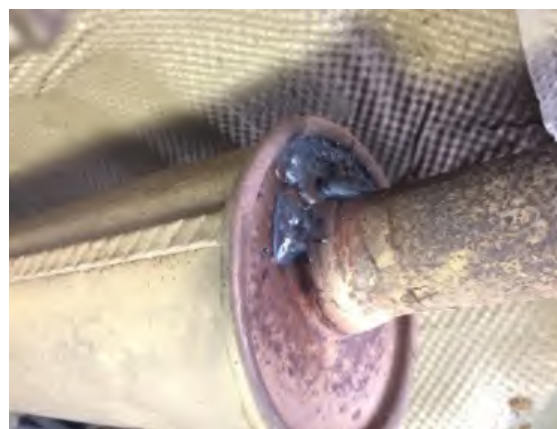
Рис. 7. Ремонт с помощью классической сварки
