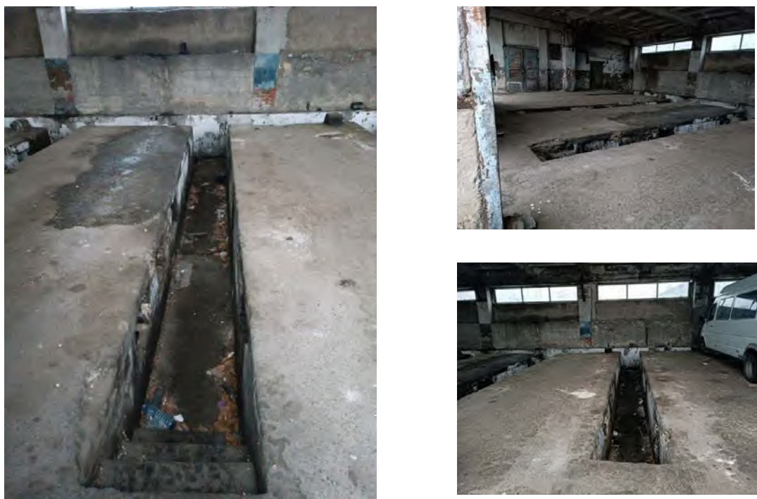
Рис. 3. Посты для выполнения работ по техническому обслуживанию и ремонту автобусов малого класса
