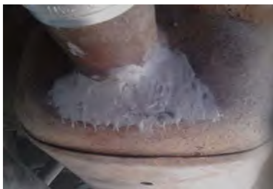
Рис. 8. Ремонт с помощью холодной сварки
